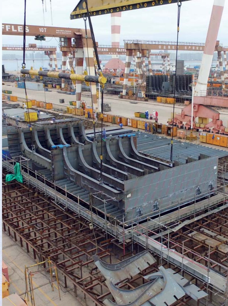
→ 陵水 17-2 气田开发工程项目 分段盖片装配
