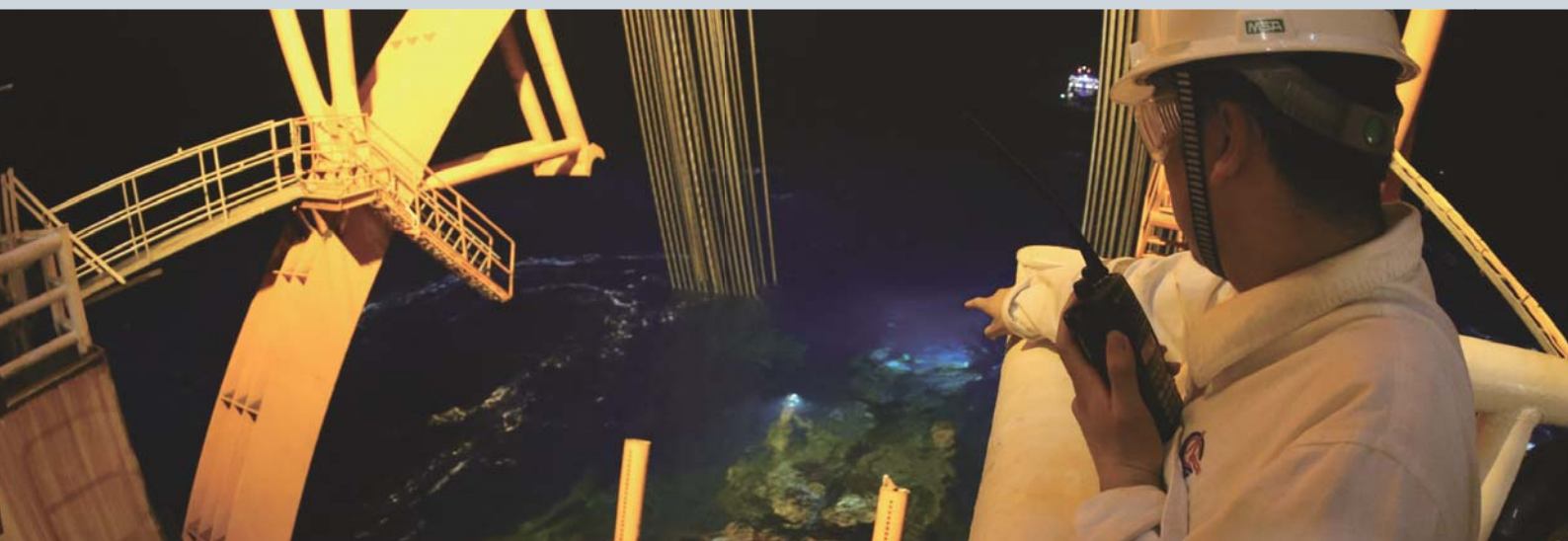
↓ 流花 16-2 油田群工程项目 海管铺设
