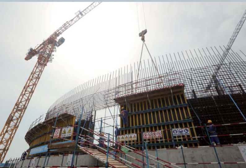
↓ 福建 LNG 接收站及储罐项目 陆地建造
