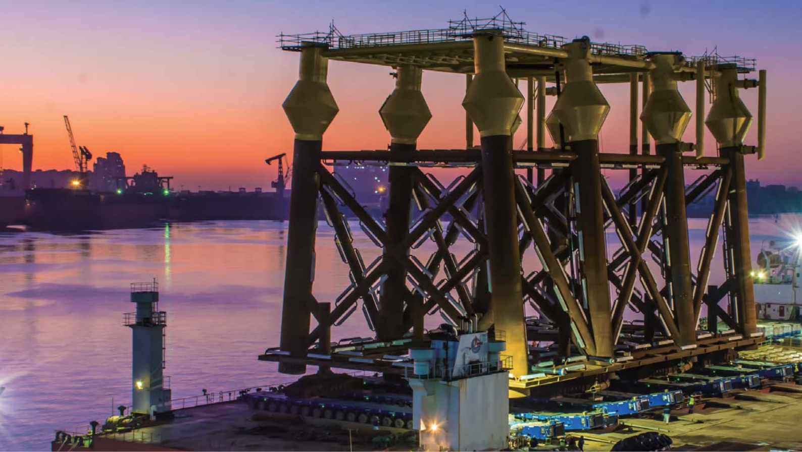
↑ 锦州 25-1 油田开发工程项目 导管架装船
