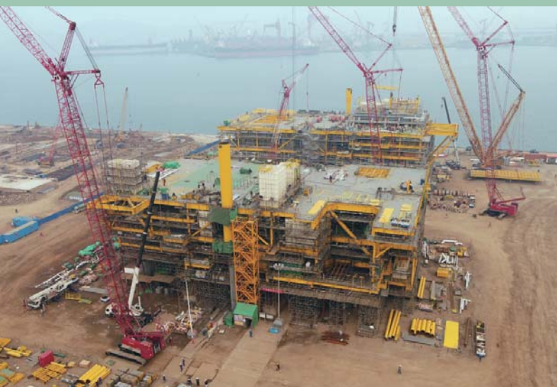
← 渤中 34-9 油田开发工程项目 陆地建造
