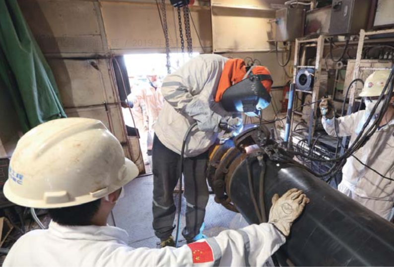
← 海管组对焊接
