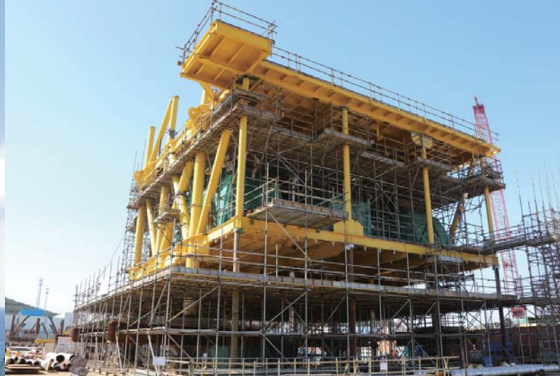
↑壳牌企鹅 FPSO 项目 上部模块陆地建造
